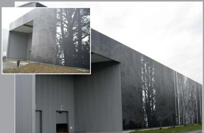
Celulosas Vascas Factory, Vizcaya. Customized Design: Jesús Jauregui. Architect: Luis Lumbreras, Bilbao Arquitectos.
